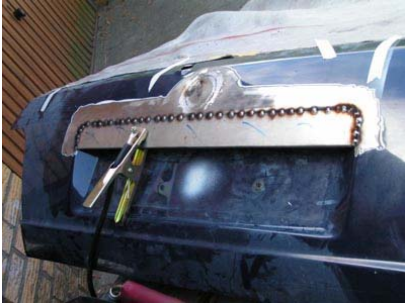
Einschweißen der Blechleiste *2
