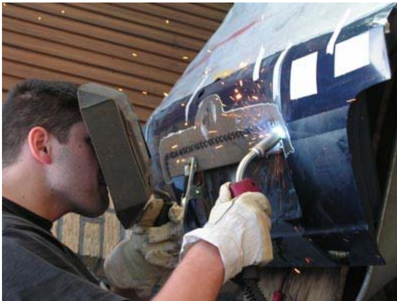
Einschweißen der Blechleiste *1
